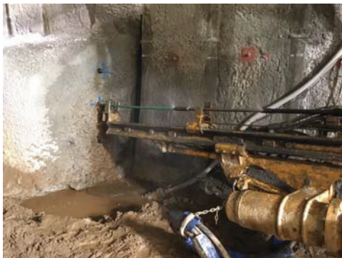
写真-4 試験施工（穿孔状況）
